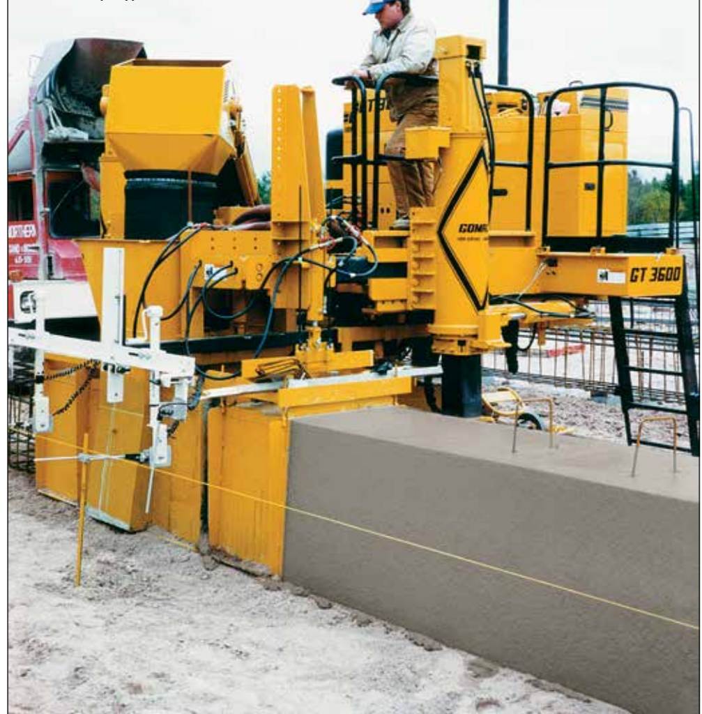
GOMACO GT-3600 бетонирует фундамент катка для фигурного канала в Мичигане
