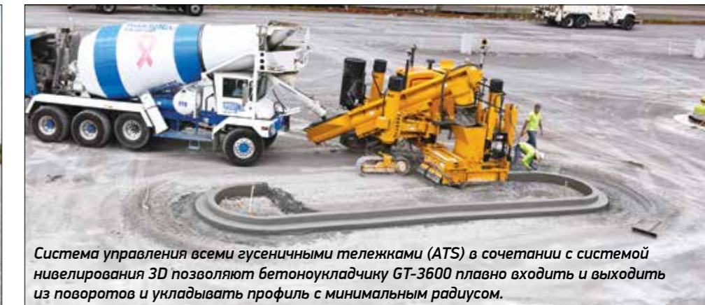
GT-3600 с системой нивелирования 3D укладывает профиль в скользящей Опалубке с радиусом 0.8 м на проекте по устройству автомобильной парковки (Теннесси, США).
