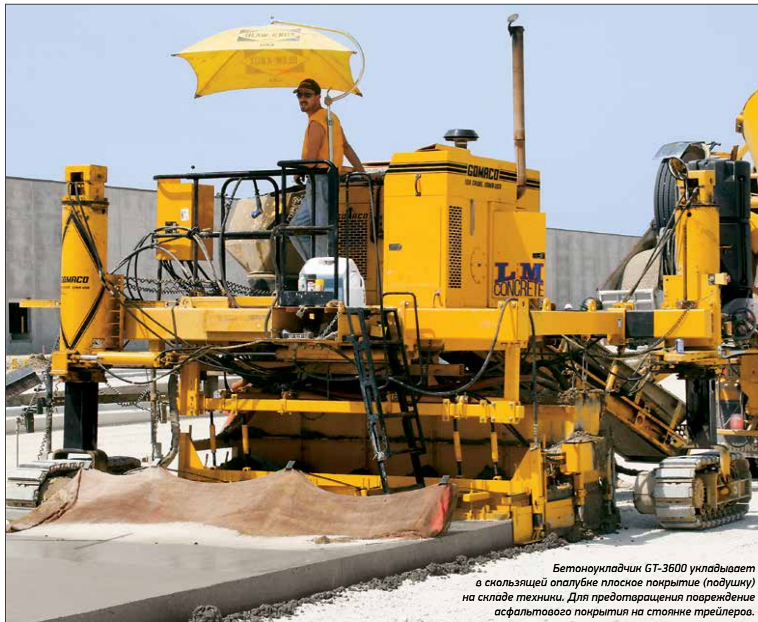
Скользящая форма с креплением по центру бетоноукладчика сконструирована по принципу «форма вокруг формы», который проиллюстрирован на рисунках оранжевым цветом.
