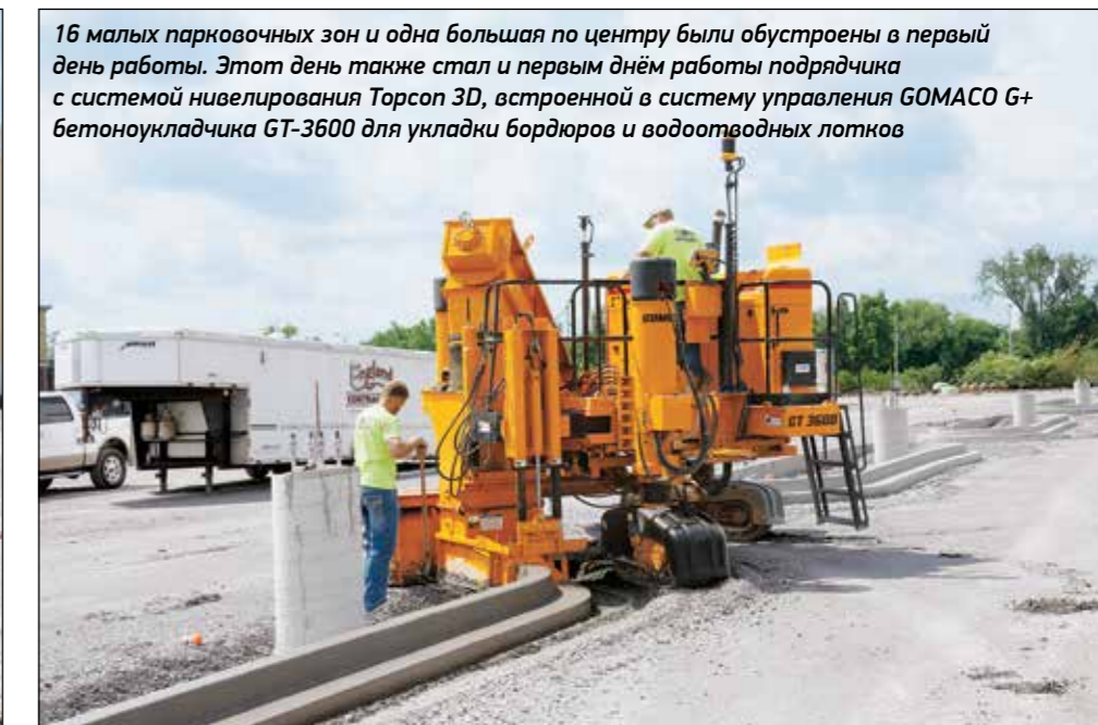
Сенсоры курса позволяют автоматически выдерживать заданную траекторию как внутренней, так и наружной кромок бордюра минимального радиуса по мере движения GT-3600
