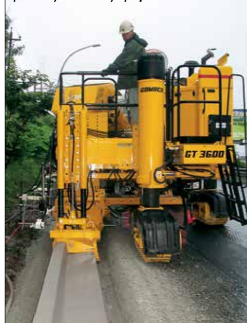
Укладка профиля с минимальным боковым зазором выполняется с помощью функции бокового смещения формы.
