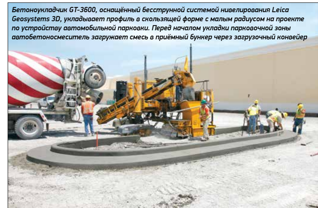
16 малых парковочных зон и одна большая по центру были обустроены в первый день работы. Этот день также стал и первым днём работы подрядчика с системой нивелирования Topcon 3D, встроенной в систему управления GOMACO G+ бетоноукладчика GT-3600 для укладки бордюров и водоотводных лотков
