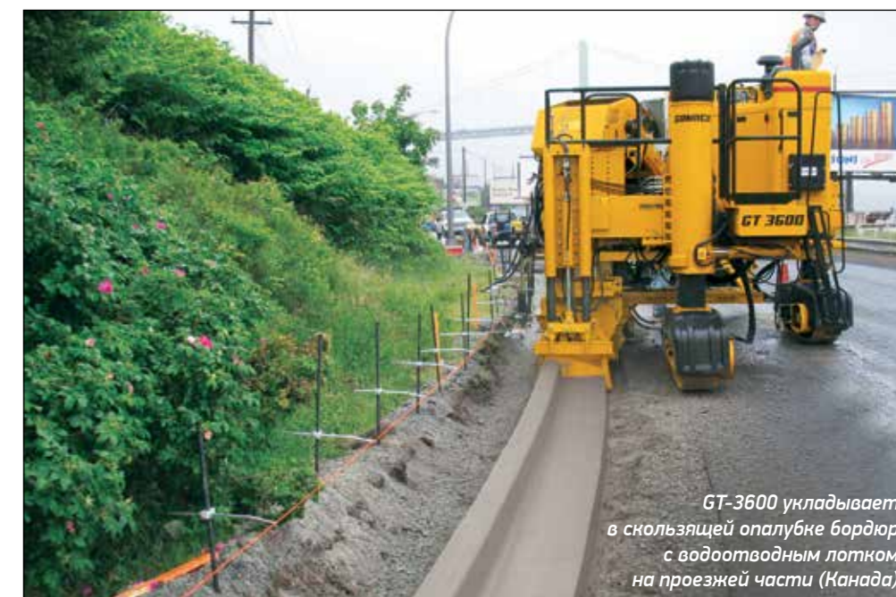
GT-3600 бетонирует непрерывную дорожку для гольф-клубов. Ширина дорожки 2,4 м, толщина 102 мм, длина 9205 м. Суммарный объем бетона для выполнения проекта составил 2309 м 3
