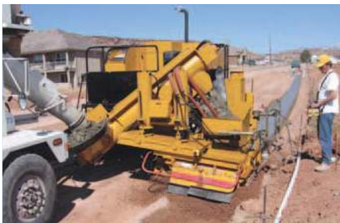
Шнековый питатель с гидравлической регулировкой перемещения до 406 мм опускается для загрузки бетона.
