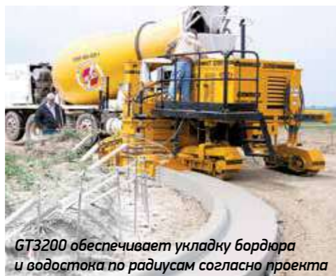
Бордюроукладчиком GT3200 можно управлять с помощью 3D системы (без струны)
