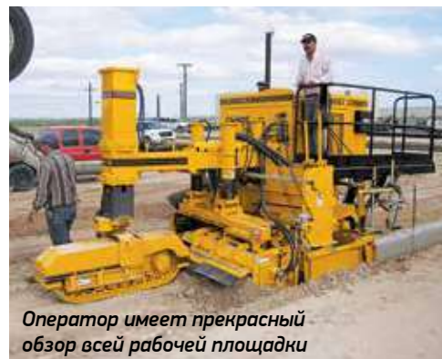
Устройство нового бордюра — первый шаг в проектах реконструкции уличных дорог
