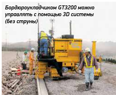
GT3200 обеспечивает укладку бордюра и водостока по радиусам согласно проекта
