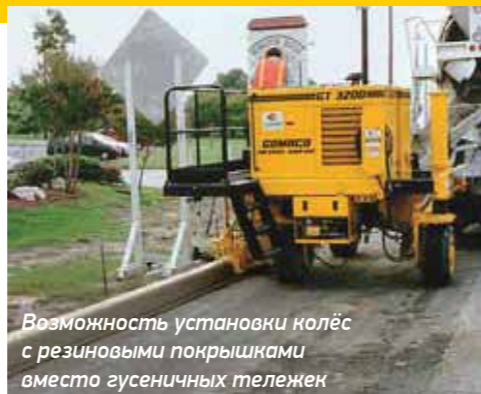
Укладка пешеходных дорожек, тротуаров
